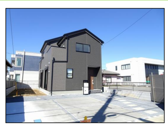
1号棟 外観写真
